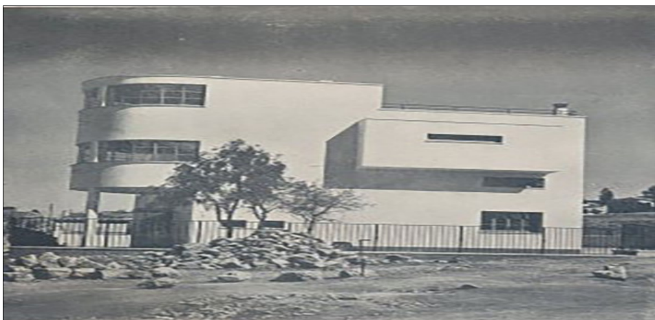
Εικόνα 2: Σχολικό κτήριο Γούβας.
