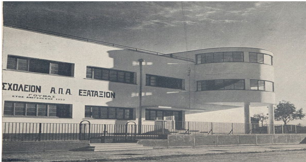
Εικόνα 5: Σχολικό κτήριο Γούβας.
